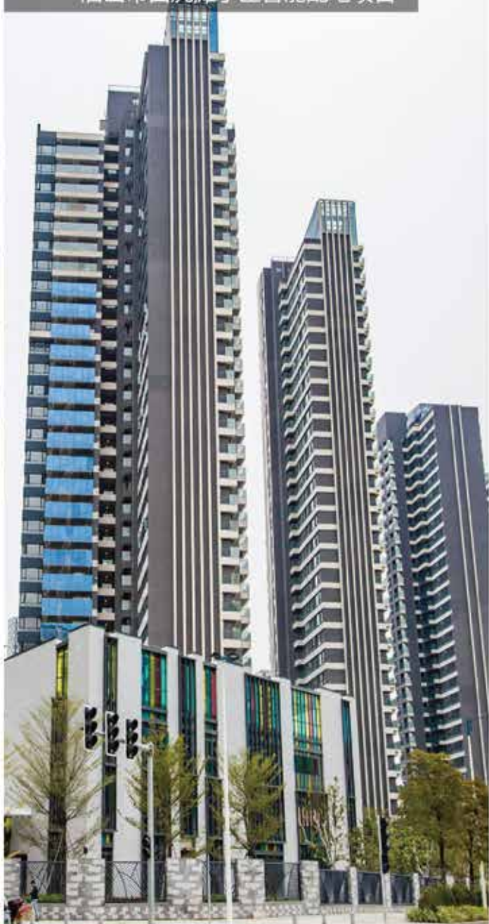
眉山市白虎滩小区智能配电项目
